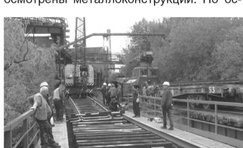
мотрены они были не все, потому что металлоконструкции были в закрытом состоянии, и было принято решение после вскрытия верхних путей и площадок ещё раз обследовать металлоконструкции и определить их состояние, чтобы полностью убедиться, что нужно менять.
