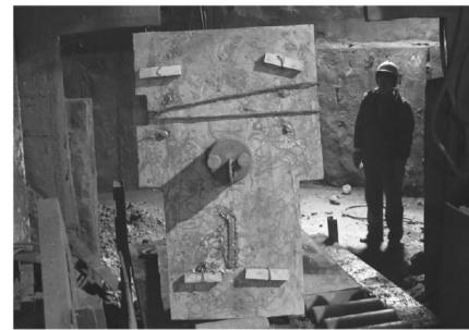
Все эти работы по выгребке шихты и демонтажу углеродистых блоков доменщики проводили своими силами с использованием гидромолота.
