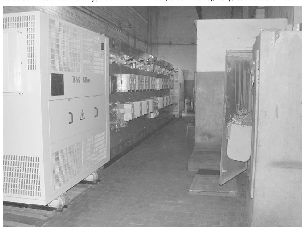
Трудно себе представить, что произойдёт с доменным цехом при отключении распредустройства, так как две высоковольтные секции распредустройства (первая и вторая) находятся в одном небольшом помещении.
