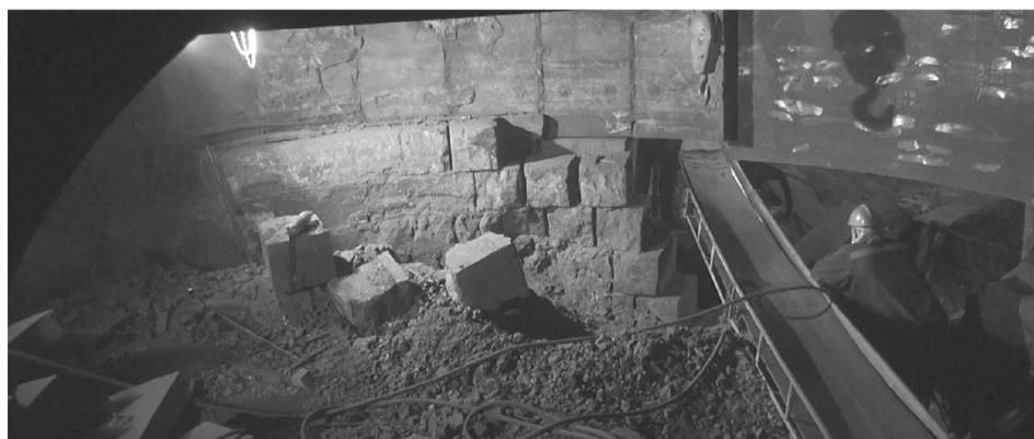
Колоссальная работа проведена по воздухонагревателям. Была восстановлена кладка штуцеров, был проведён торкрет-ремонт на 2-м и 3-м воздухонагревателях, частичный ремонт проведён на 4-м.
